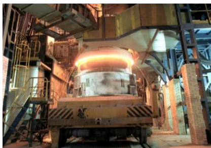
Рис. 53. «НКМЗ». Установка внепечной обработки стали «Ковш-печь»
